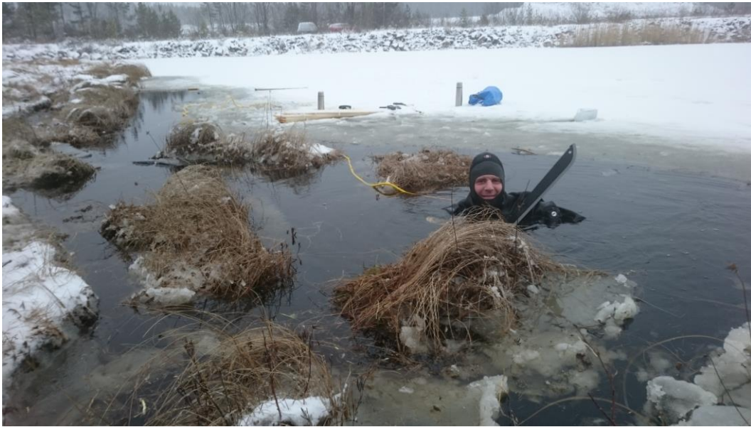
Figur 3. Lossning av gungfly med hjälp av dykare utrustad med machete och issåg. Dykare: Gustav Björnstad. Foto: Johan Kjellin.
