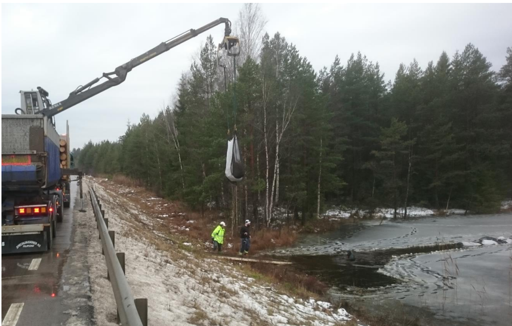
Figur 6. Nedsänkning av gungfly i Gåstjärnen. Foto: Johan Kjellin.
