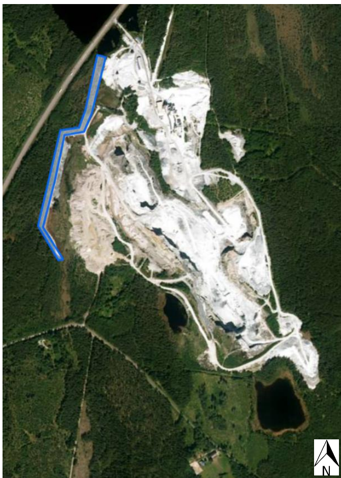
Figur 2. Den översta delen av Rävbäcken är uträtad och nyligen dikad. Denna sträcka är cirka 750 meter. Hela Rävbäcken är cirka 3 kilometer lång.
