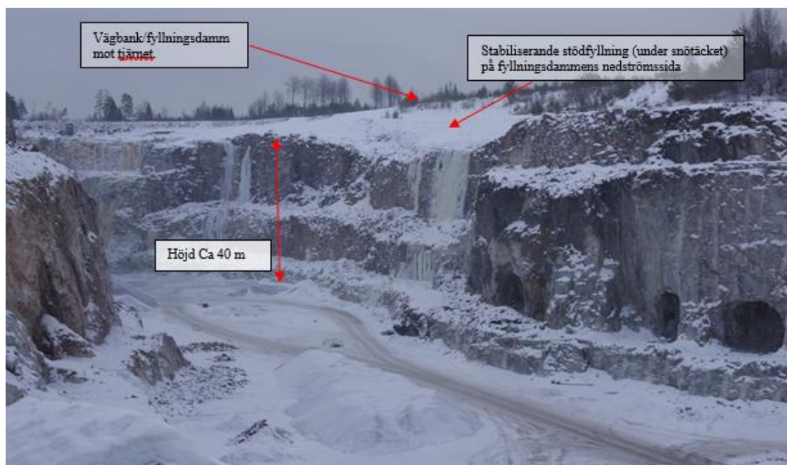
Figur 12: Visar västra slänten i södergående riktning. (Bild källa: SMA Mineral Persberg AB, 2021-03-31).
